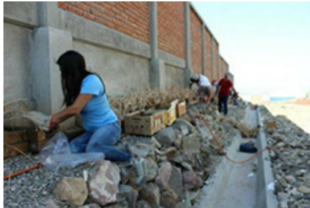
Figura 4. Perímetro escolar. Fuente: Banco de imágenes del Grupo Eco.
